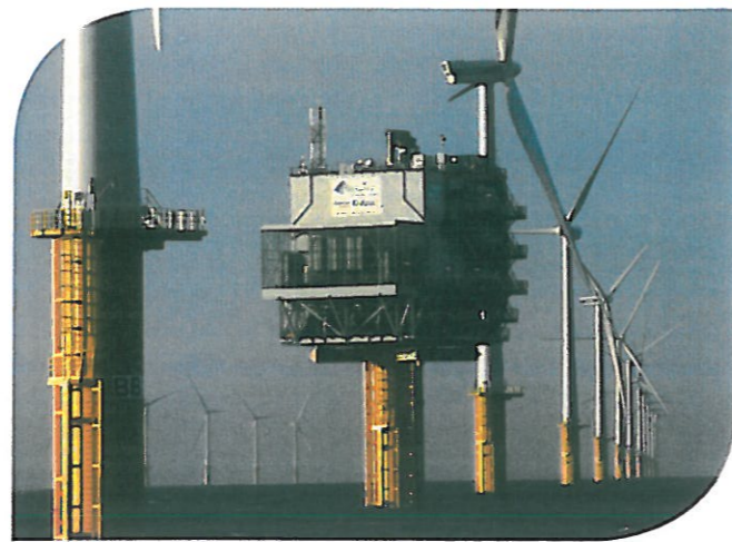
bouw van een transformatorstation voor het windmolenpark Belwind Wind Farm, zo'n 50 kilometer ver in zee, voor de kust van Zeebrugge, ter hoogte van de Bligh-bank – © lemants
